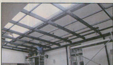
Átrium tető, építés közben
